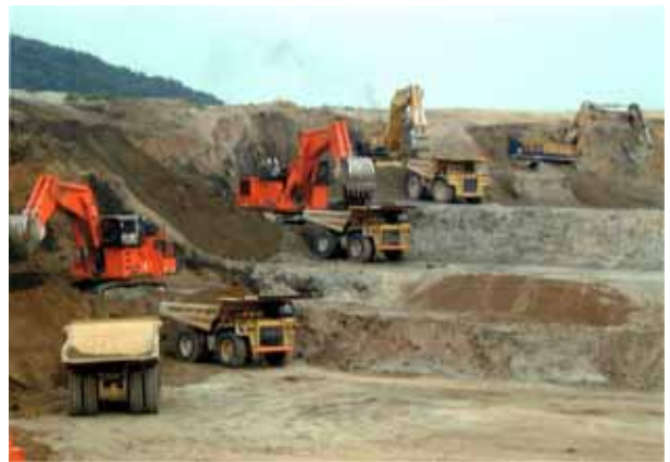
写真-5 190tショベルと90tダンプ（谷浜造成）
