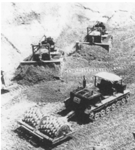
写真-3 信濃川発電所コア締固め
