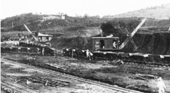
写真-1 山口調整池工事の土取場
